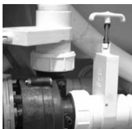
Vanne guillotine et Raccord de pompe
